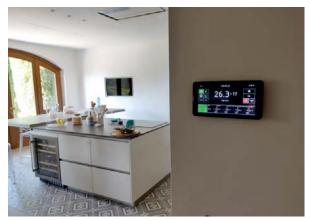
L'interfaccia Wi-fi posta all'interno dell'abitazione si connette alla centralina permettendo il controllo delle funzioni di accensione spegnimento del generatore nonché inversione dello stesso nella funzione estate
